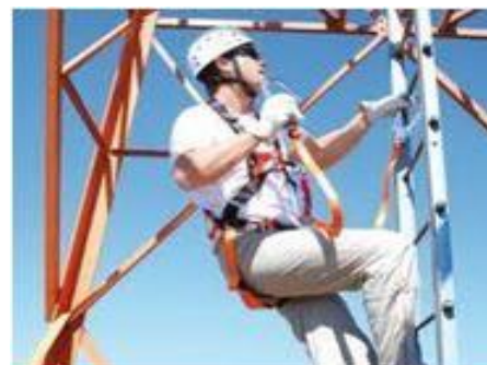
Escalada em estrutura metálica
